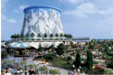
Koeltoren 1998 - 1999 Kalkar (DE) 50m x 300m
